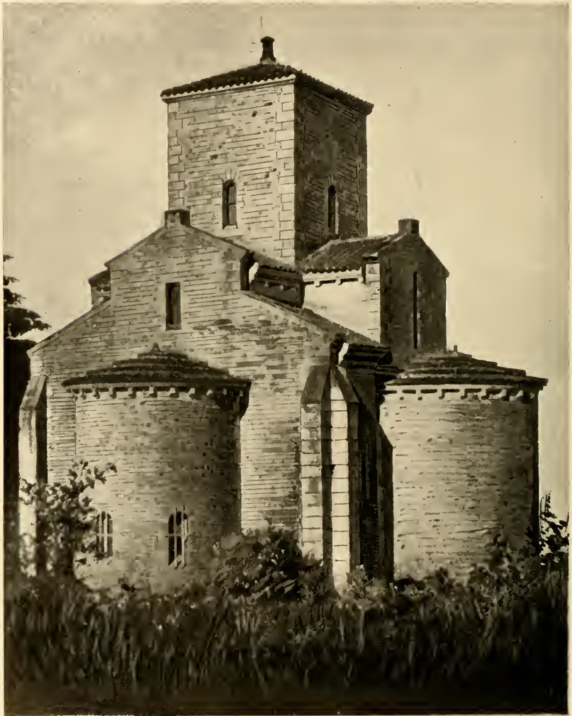
Fig. 293 — Veduta esterna della basilica di Germigny-des-Prés (n. 801-806)
